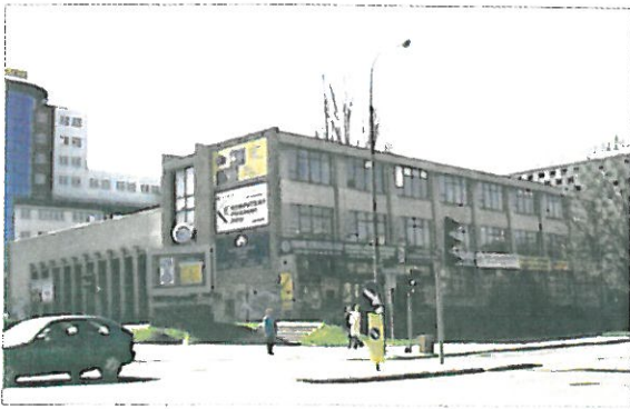
Rys. 3. Budynek NOT „Dom Technika” w Białymstoku (przed modernizacją)
