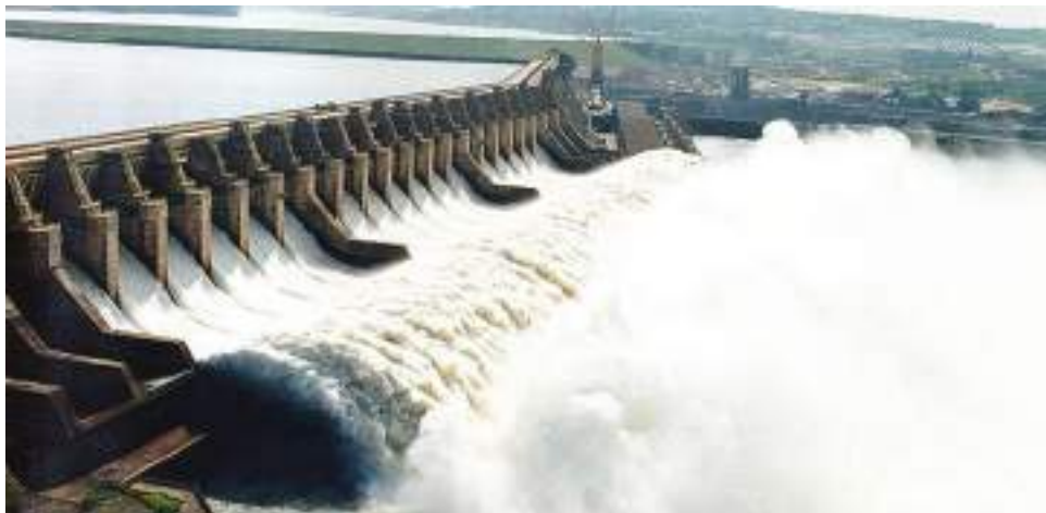
Fot.6. Hydroelektrownia Tucuruí w Brazylii
