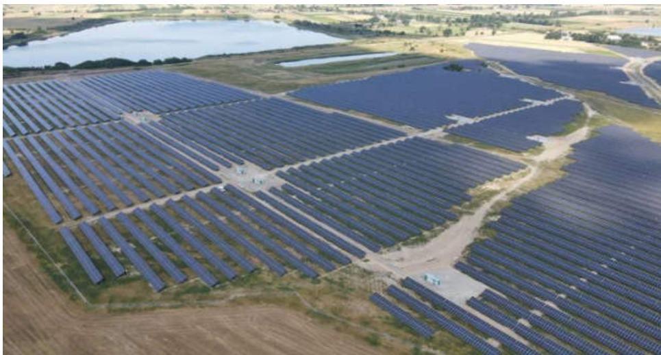
Fot.2. Widok farmy fotowoltaicznej Brudzew z lotu ptaka
