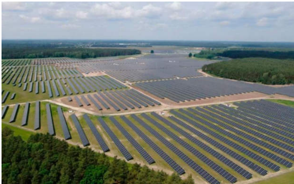
Fot.4. Widok farmy fotowoltaicznej Wielbark z lotu ptaka
