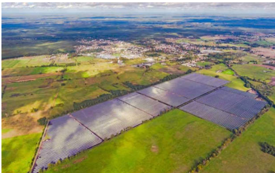
Fot.3. Widok farmy fotowoltaicznej Witnica z lotu ptaka
