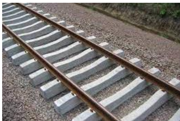
Fot. 15. Klejowe podkłady żelbetowe
