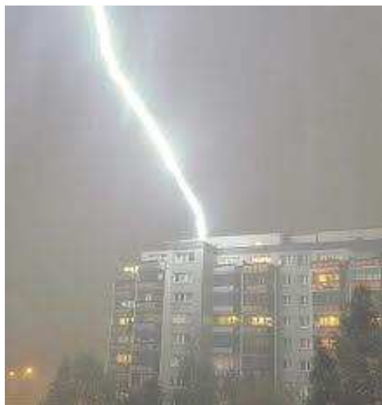
Fot.6. Uderzenie pioruna w blok mieszkalny
