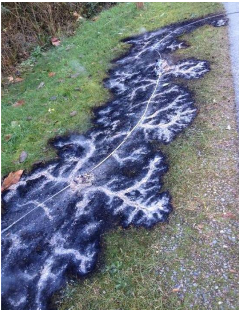
Fot.3. Wzór jaki na trawniku zostawiła zerwana linia energetyczna
